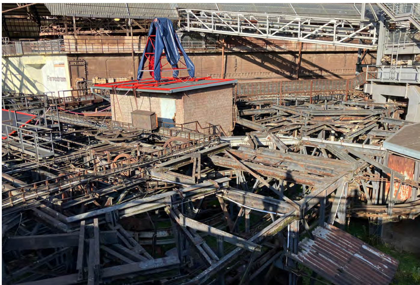
Zásobovací dráha k vysokým pecím.
