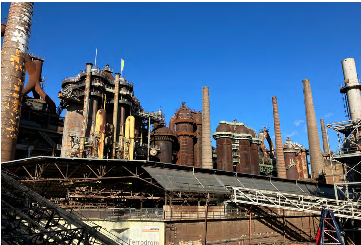
Pohled na vysoké pece a jejich zachování.
